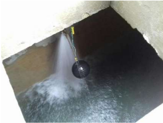
Cambio de válvula y boya del tanque de captación de agua .
