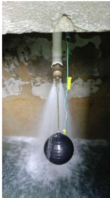
Cambio de válvula y boya del tanque de captación de agua .
