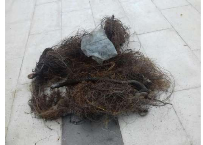
Extracción de raíces que dificultaban el trabajo normal de la válvula y boya.
