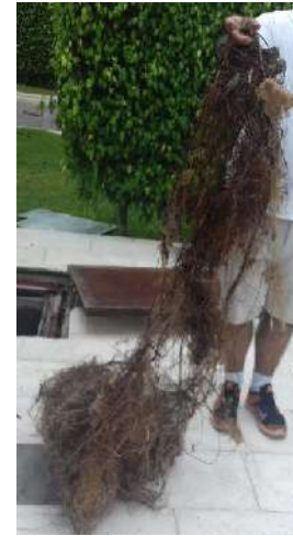
Extracción de raíces que dificultaban el trabajo normal de la válvula y boya.
